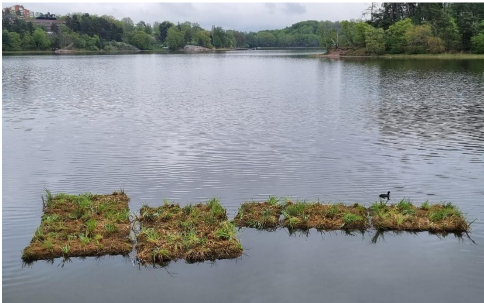
Foto: Rikard Dahlén. Flytande våtmark, moduler 2 kvm kopplas ihop till enheter på mellan 8-10 kvm.
