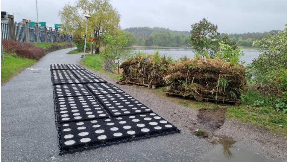
Foto: Rikard Dahlén. Flytande våtmark, moduler 2 kvm kopplas ihop till enheter på mellan 8-10 kvm.
